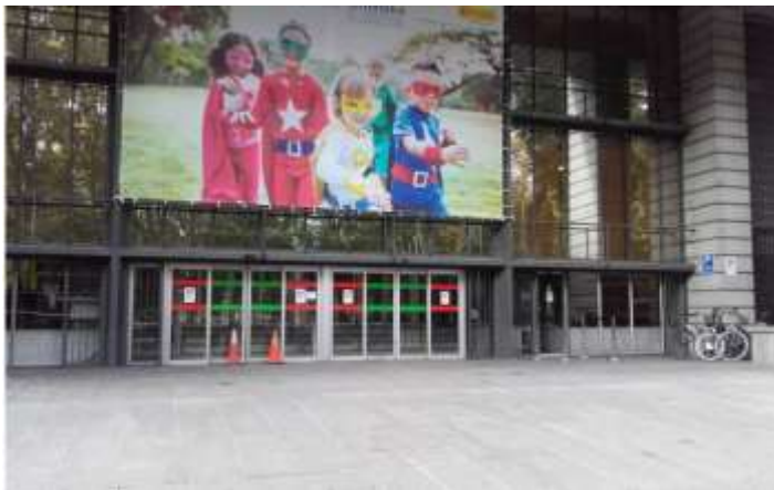
SALIDA C/ PASEO DEL PRADO PUERTA PRINCIPAL EXPLANADA
